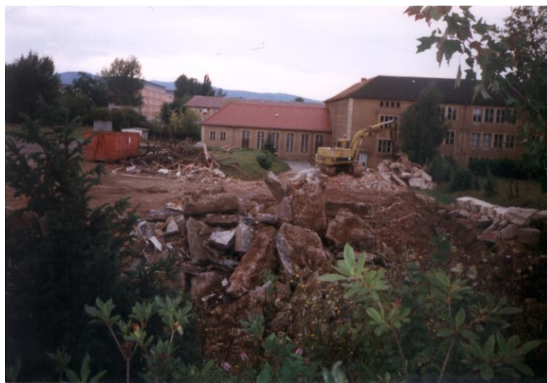
Bild 30: Abriss 1998 des 1978 gebauten Boxraumes
